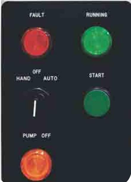
Панель, расположенная на передней поверхности каждого устройства SALT, обеспечивает прямой доступ к основным возможностям управления и данным о состоянии системы.
