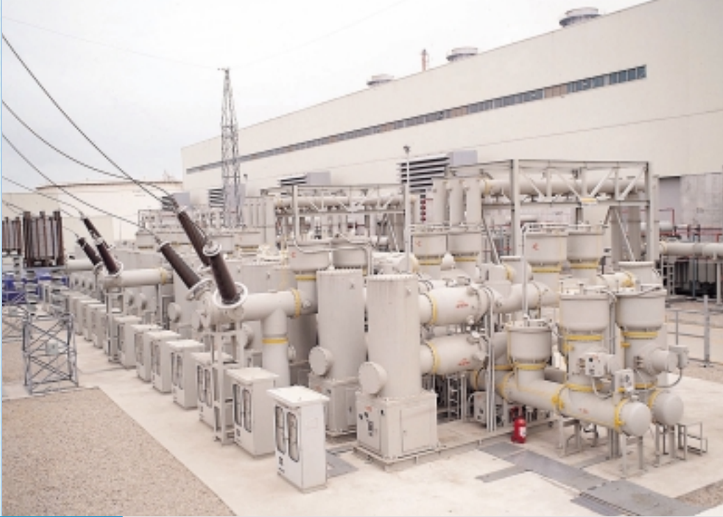
145 SP-1 Switchgear
